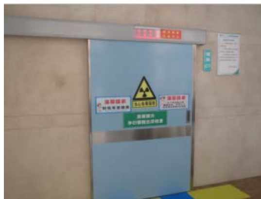
东芝 16 排 CT 机房防护门警示灯及警示标志
